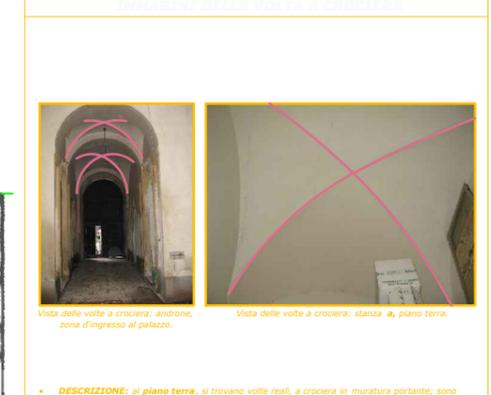
DESCRIZIONE: al piano terra, si trovano volte reali, a crociera in muratura portante; sono geometricamente composte dall'intersezione ortogonale di due volte a botte. Se la pianta è quadrata (in due volte a botte hanno le direttrici uguali (stessa forma, stessa corda e uguale monti); se la pianta è rettangolare le direttrici saranno una un semicerchio e l'altra una semiellisse, corda diversa ed uguale monti.
