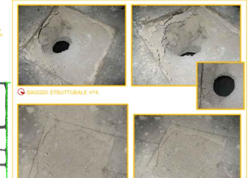
DESCRIZIONE: volte sottili a schifo, costituite da pietrame e malta di gesso.
